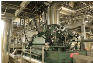
原子炉隔離時冷却系 (RCIC)
