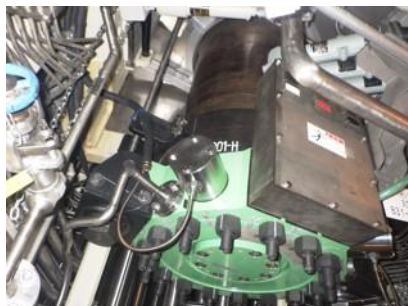
原子炉内蔵型再循環ポンプ
