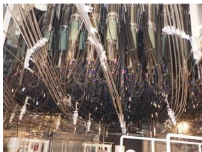
制御棒駆動機構
