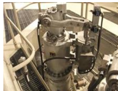
主蒸気隔離弁
