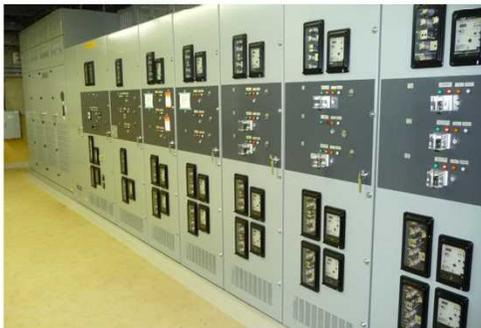
1号機 電源盤 (P/C 1C-1) 据付後
