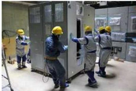
1号機 電源盤 (P/C 1C-1) 据付作業
