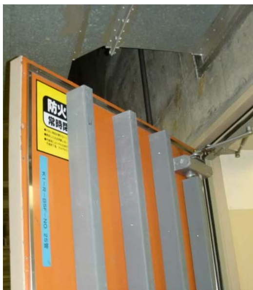
補強鋼材取付
