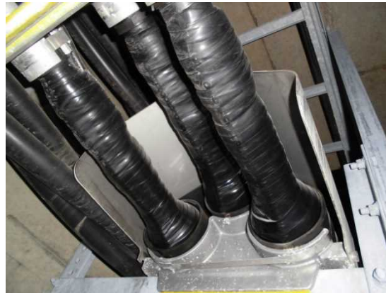
<66kV GIS～LSTr6SB間の接続部>
