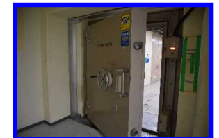
水密扉等の溢水対策 (屋内複数箇所)
