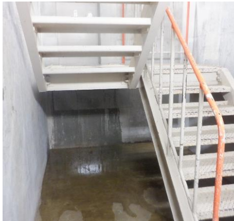
北西階段室の状況
