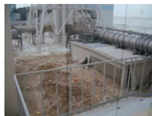
敷地内に津波が浸水
