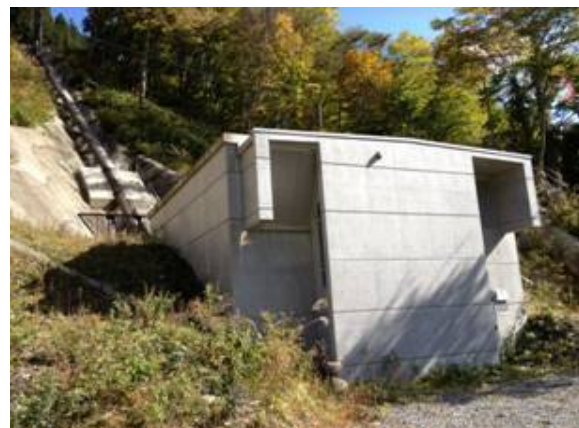
栃川発電所(長野県栄村)
