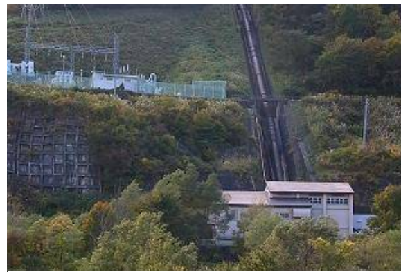
清津川発電所(新潟県湯沢町)
