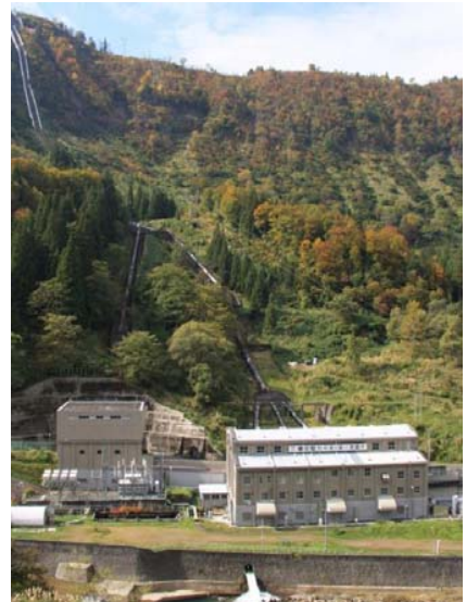
中津川第一発電所(新潟県津南町)
