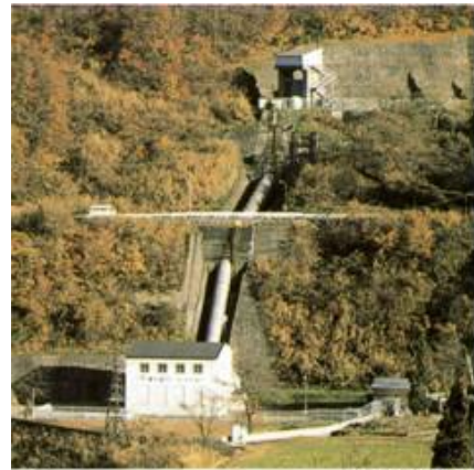
下船渡発電所(新潟県津南町)
