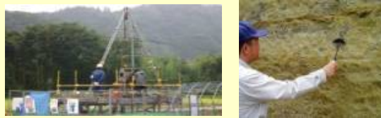
<ボーリング調査>
