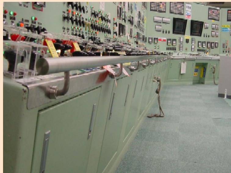
中央制御室の操作盤に手すりを設置
