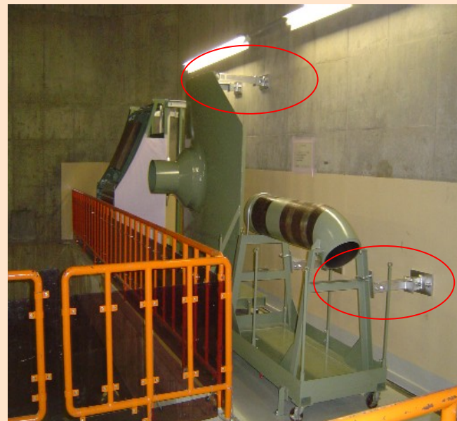
新たにサポート器具を設置
