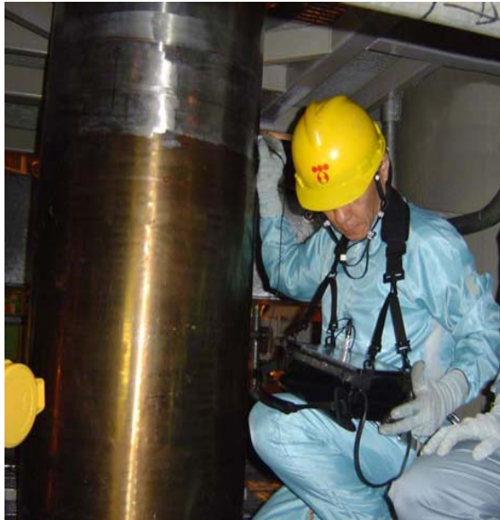
現場でのUT検査の様子
