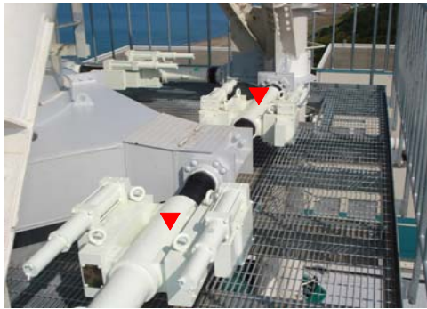
制震オイルダンパー設置イメージ
