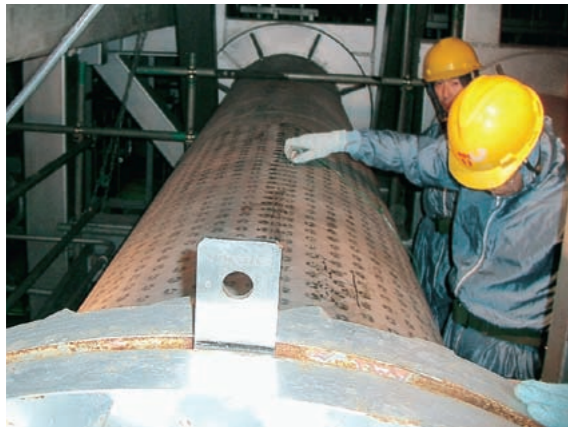
配管の点検(超音波探傷検査)
