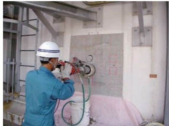
原子炉建屋コンクリートの点検
