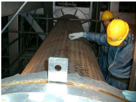
配管の点検（超音波探傷検査）
