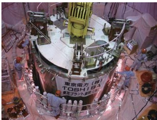
原子炉内のシュラウドの取替
