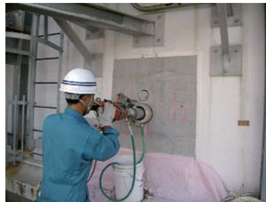
原子炉建屋コンクリートの点検
