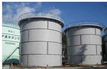
確証試験を行っている フランジ型タンク
