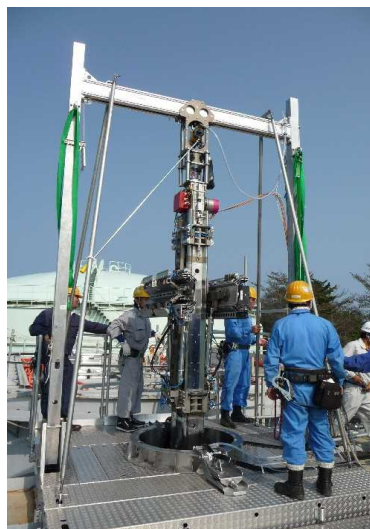
タンク底部の接続面を補修する装置
