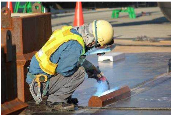
溶接型タンクの作業風景
