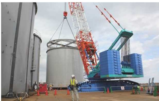
大型クレーン（吊上荷重約500t）での 輸送船へのタンクの移動
