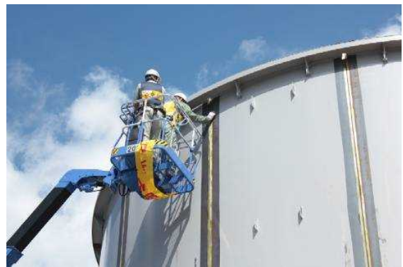
溶接箇所を確認をしている様子
