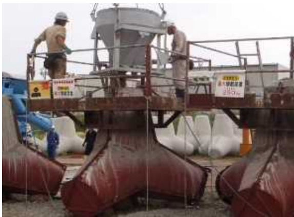
型枠へのコンクリート流し込み
