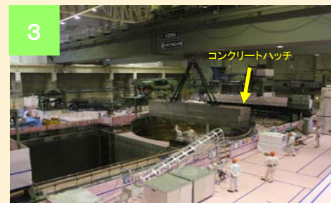
コンクリートハッチの取り外しの様子 (平成25年8月26日撮影)
