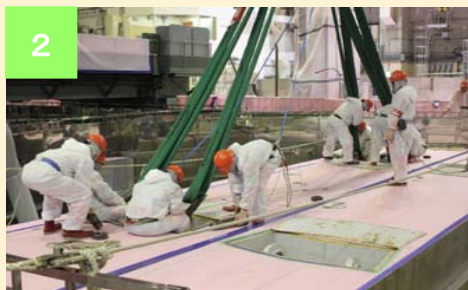
コンクリートハッチの取り外し作業の様子 (平成25年8月26日撮影)
