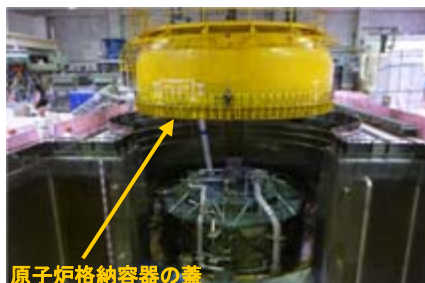
原子炉格納容器蓋の取外作業 (平成25年8月27日撮影)
