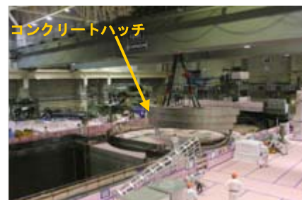
コンクリートハッチの取外作業 (平成25年8月26日撮影)
