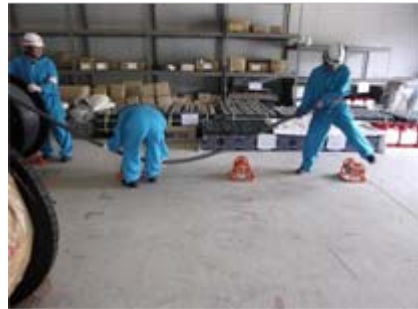
上の写真は、ケーブルを引き出すためにドラムを吊り上げた後、ケーブル引き出し、布設する訓練を行っている様子です（平成25年7月19日実施）。
