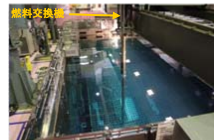
燃料移動作業の様子（使用済燃料プール） (平成25年9月19日撮影)
