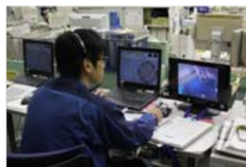
中央制御室 (平成25年10月16日撮影)
