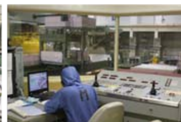
燃料交換機操作室 (平成25年10月16日撮影)
