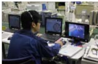
中央制御室 (平成25年10月16日撮影)
