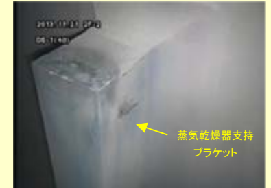
蒸気乾燥器支持ブラケット (平成25年11月21日撮影)
