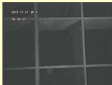
上部格子板グリッドプレート (平成25年11月27日撮影)
