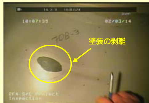
圧力抑制室内の床面 (平成26年2月3日撮影)
