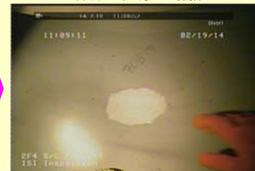
塗装補修後 (平成26年2月19日撮影)
