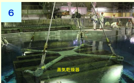
蒸気乾燥器の取り外しの様子 (平成26年5月26日撮影)
