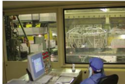
燃料交換機操作室から全体の状況を確認する監視員
