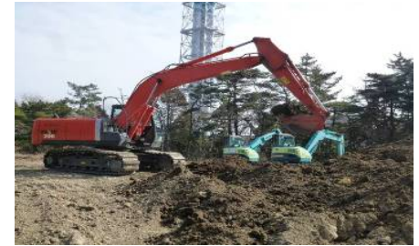
ガレキ撤去用重機の運転訓練
