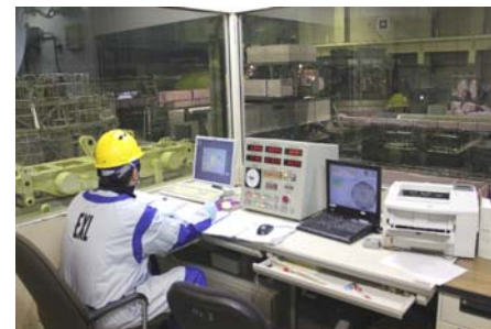
燃料交換機室
