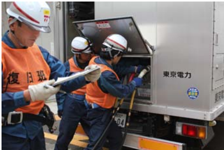
電源車へのケーブル接続
