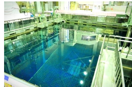
4号機使用済燃料プール (平成28年8月24日撮影)
