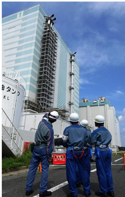
作業と安全対策の現場確認
