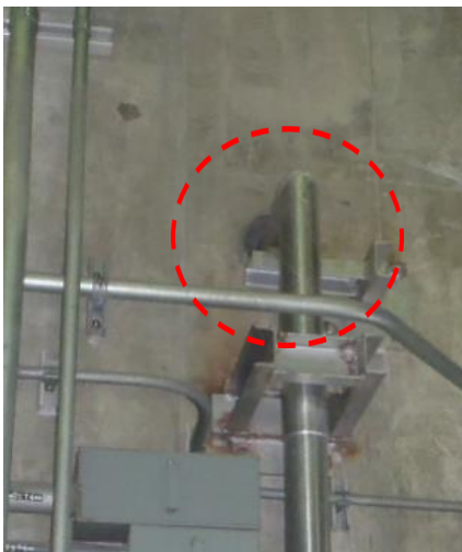
1号機タービン建屋 1階機械工作室
