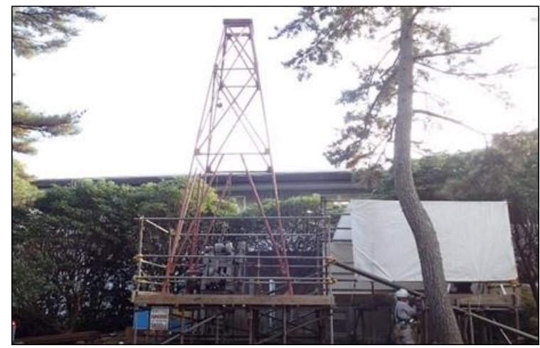
ボーリング調査状況
