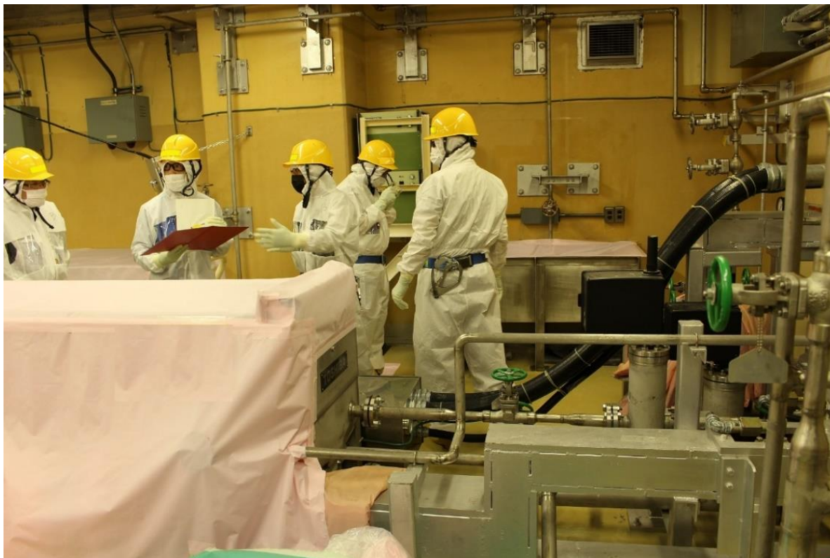
安全点検を実施している様子
