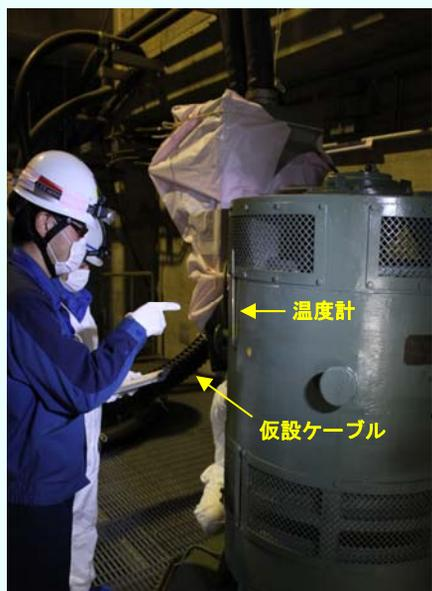
③電動機据付後の機能確認
