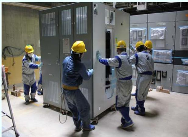
③吊下げ後の電源盤(P/C 1C-1)移動作業
