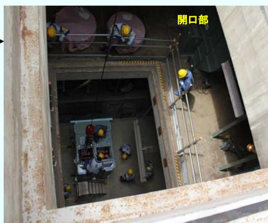
②電源盤(P/C 1C-1)の吊込作業
