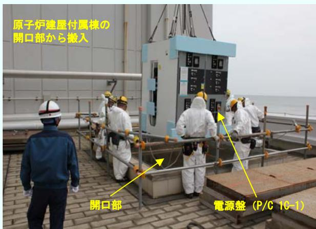
①電源盤(P/C 1C-1)の吊込作業
