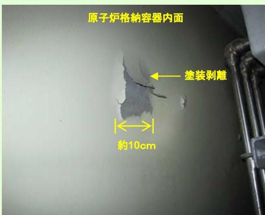
⑦原子炉格納容器内面の塗装剥離
