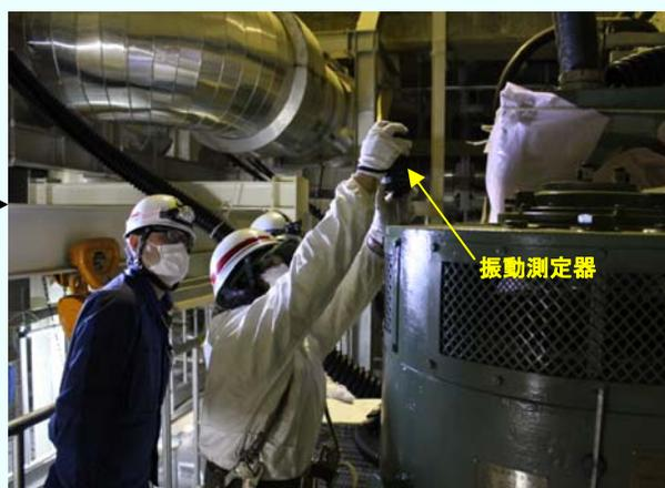
④電動機据付後の機能確認
