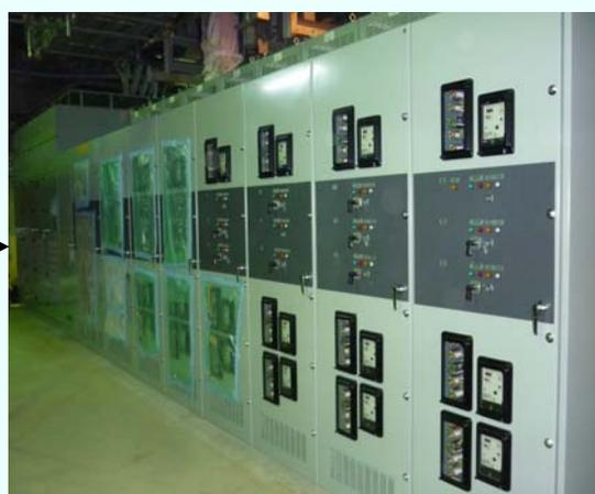
④電源盤(P/C 1C-1)据付完了
