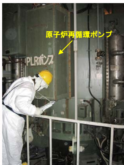
③目視点検の様子(その1) （平成24年5月10日撮影）
