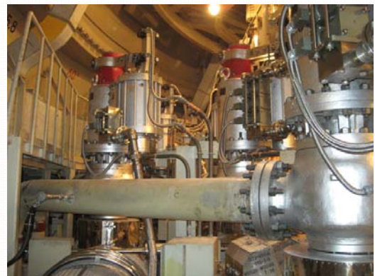
②原子炉格納容器内（主蒸気逃がし安全弁） の状況（平成24年4月17日撮影）
