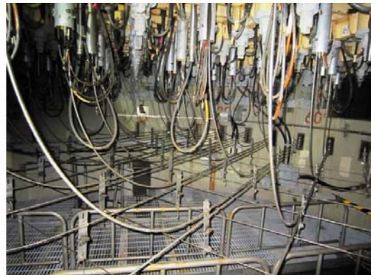
⑥ペDESTAL部(原子炉圧力容器の基礎台) (平成24年5月10日撮影)
