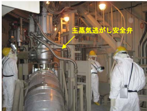
⑤目視点検の様子(その2) (平成24年5月10日撮影)
