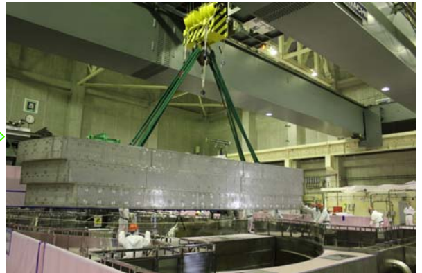
コンクリートハッチ取り外し作業 (平成24年9月10日撮影)
