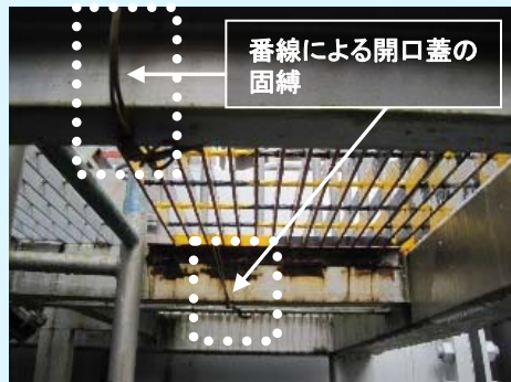
開口蓋を作業床下の梁に固縛
