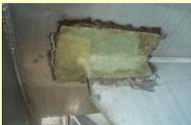
ひびが確認された箇所 (ダクト外表面) にFRPシートによる応急補修を実施。
