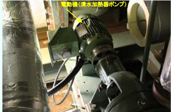
電動機(清水加熱器ポンプ※1)据付完了の様子
