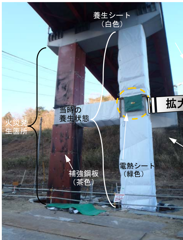
発生当時の養生状態
