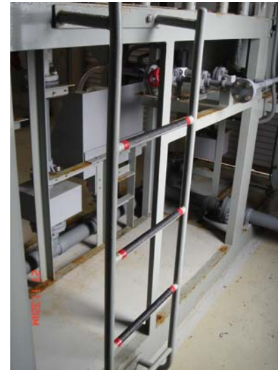
（梯子の滑り止めテープ貼り付け）
