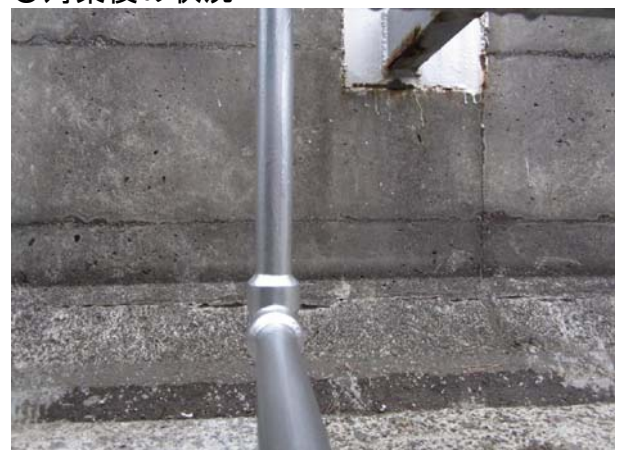
配管を新品に交換
