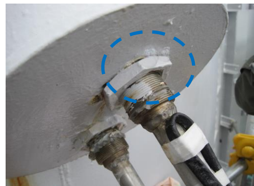
空気漏えいを確認した配管貫通部
