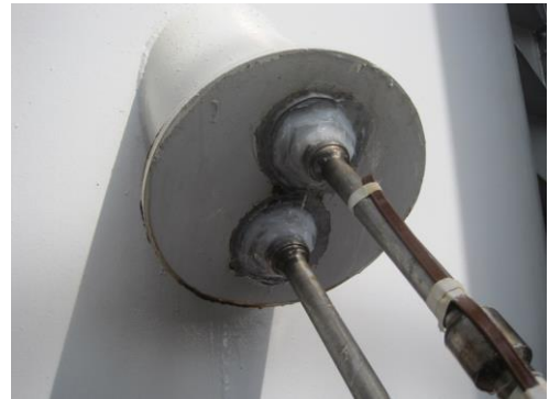
応急処置（シール材塗布）の状況
