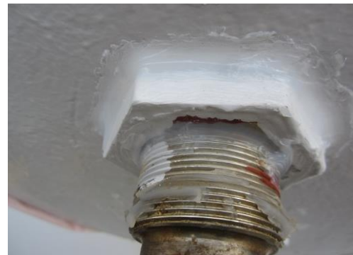
応急処置（シール材塗布）の状況
