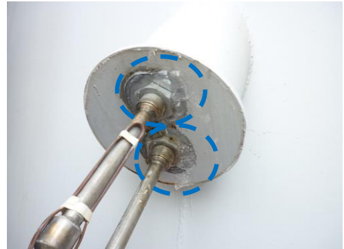
空気漏えいを確認した配管貫通部
