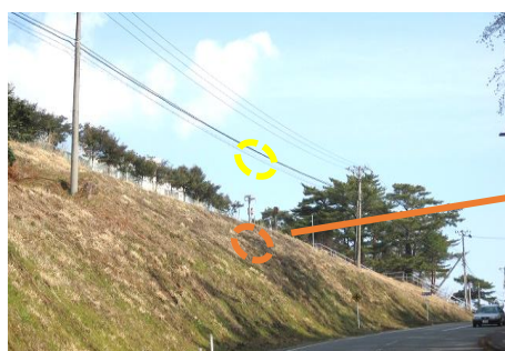
法面(南から撮影)
