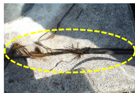
焼損した光ケーブル
