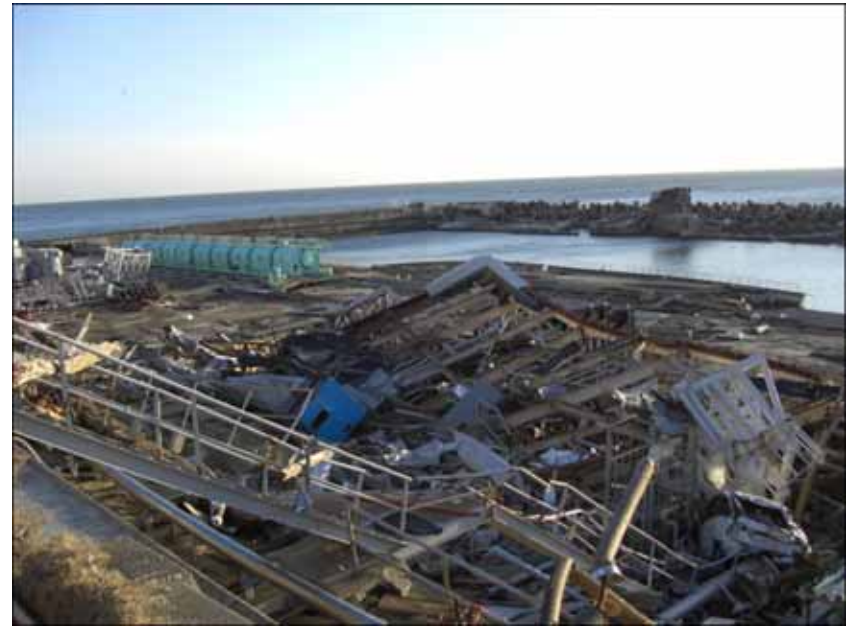
5・6号機取水設備周辺を撮影
