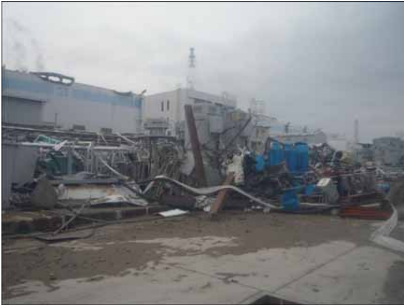
3号機海水ポンプエリア近傍を撮影
