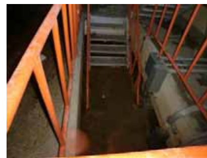
3号機階段室 (北西)
