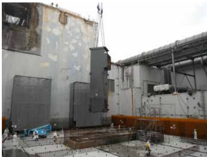
1本目建方状況
