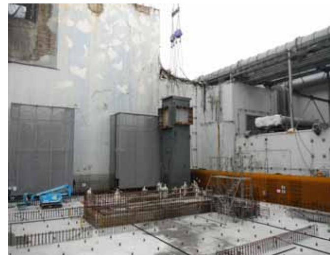
1本目設置完了
