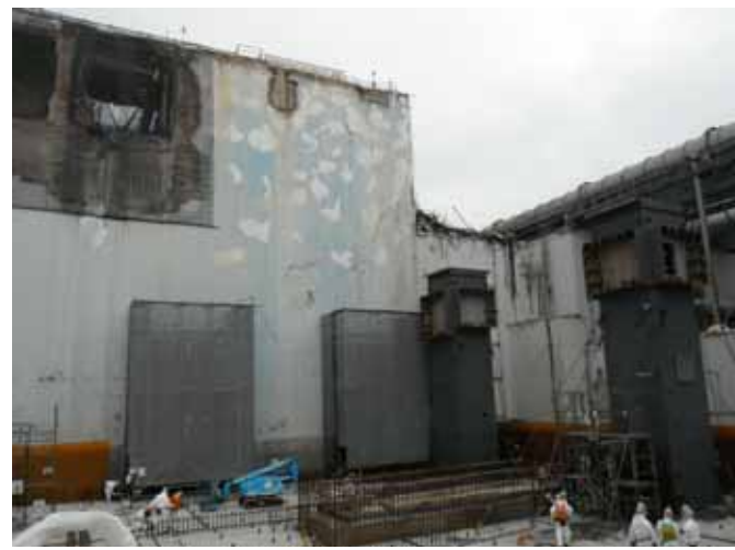
2本目設置完了
