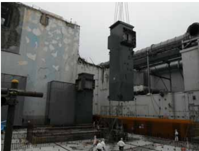
2本目建方状況
