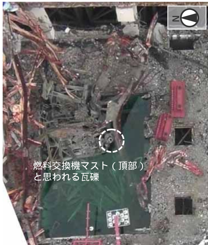
瓦礫撤去作業前（平成25年2月4日撮影）
