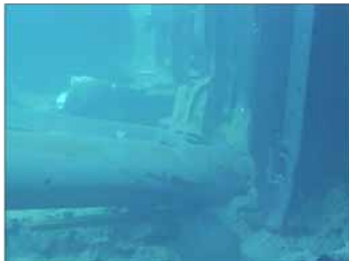
燃料交換機マスト瓦礫の状況（下端） （平成25年2月13日撮影）
