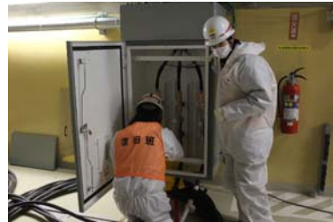
ケーブル接続箱へのつなぎ込み（2号機）
