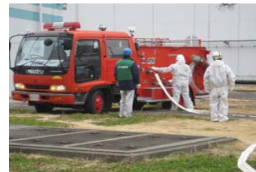
原子炉建屋への送水準備（2号機）
