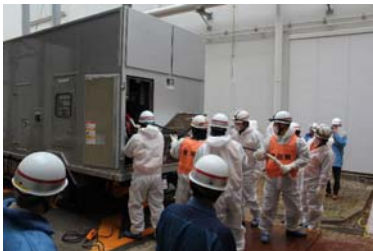
電源車からのケーブル引き出し（2号機）
