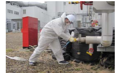
原子炉建屋への送水（2号機）
