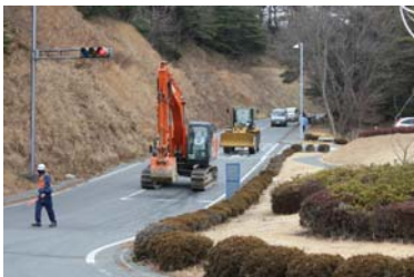
現場へ向かう重機
