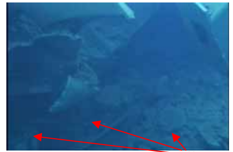
画像 : 燃料交換機の下部と燃料ラックの状況
