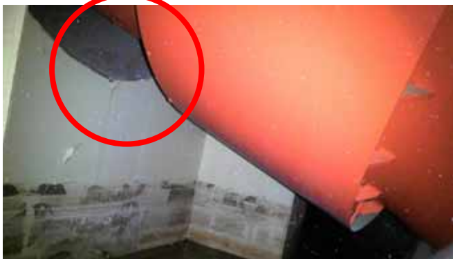
ベント管スリーブ端部
